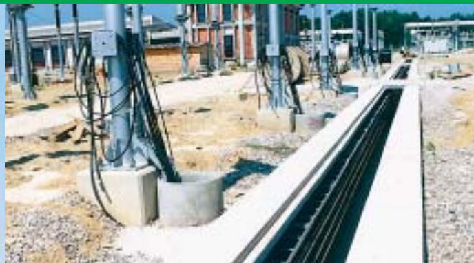
Povučeni kabeli pripremaju se za spajanje na VN aparate u RP 400 kV
