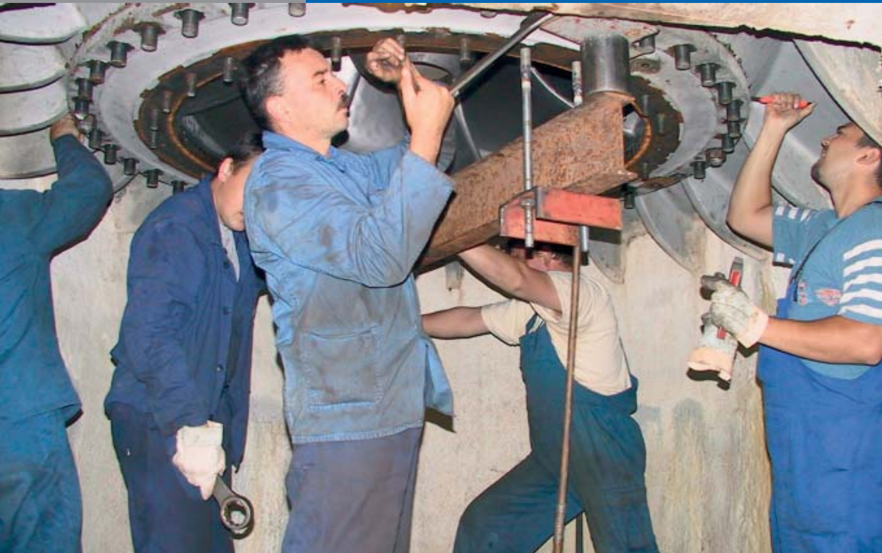
Radnici CHE Fužine na poslu u podnožju generatora
