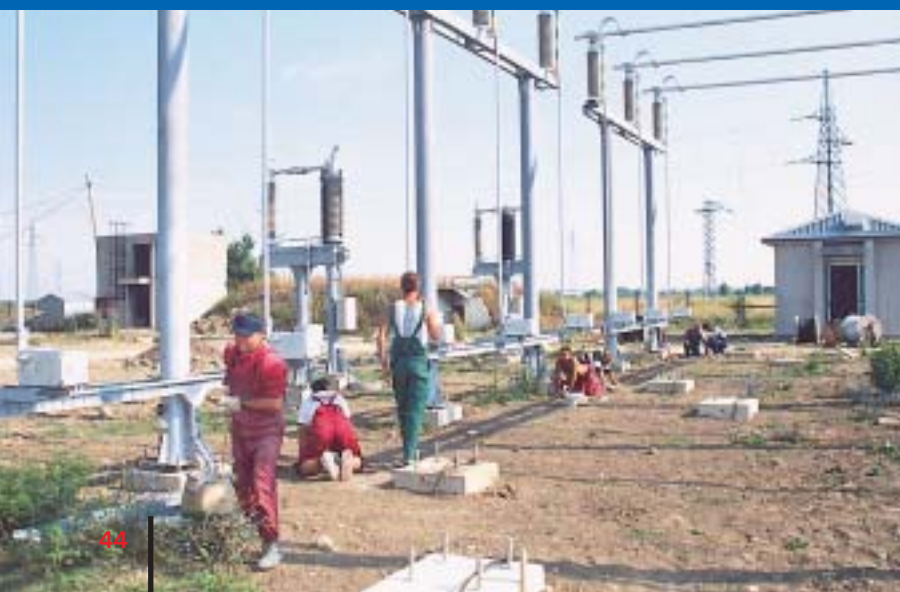
Kabeli se razvlače kroz kablsku kanalizaciju
