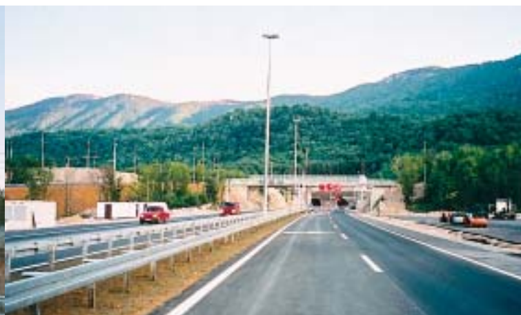
Ulaz u tunel Sv. Rok s ličke strane: je li to mogao biti prolaz za kabelsku dionicu budućeg voda 400 kV?
