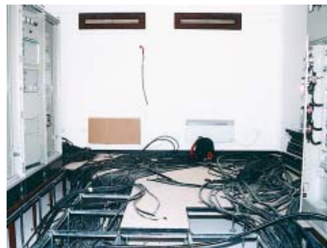
Upravljačko signalni kabeli u RK 101 su položeni i slijedi povezivanje
