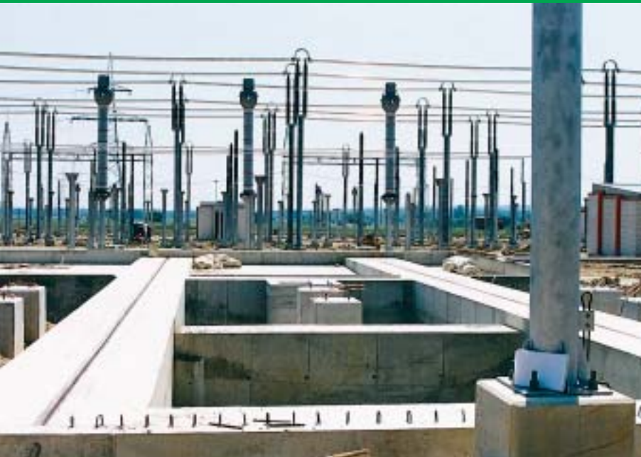
Navozne grede i temelj čekaju transformator T2 400/110 kV, 300 MVA
