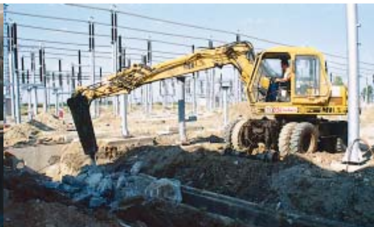
Treba ukloniti još deset metara starog kablskog kanala
