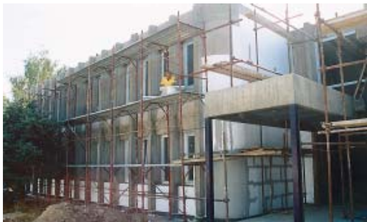
Završni radovi na upravljačkoj zgradi - postavlja se toplinska izolacija
