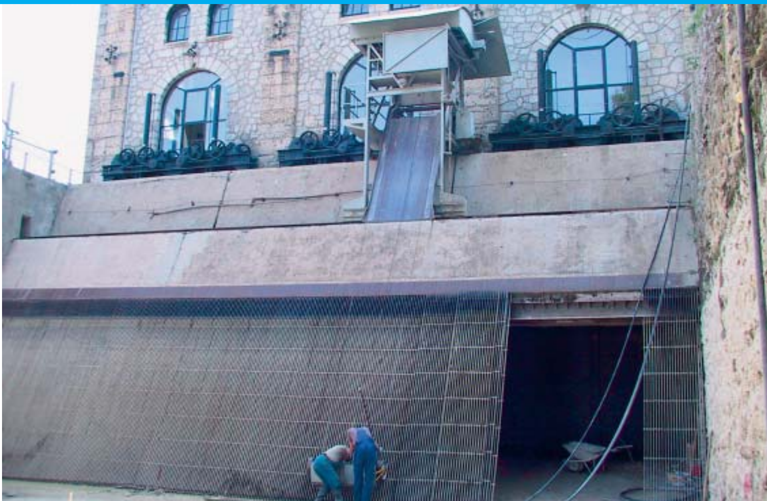
Zahtjevni radovi na sanaciji temeljenog tla i zgrada HE Ozalj 1
