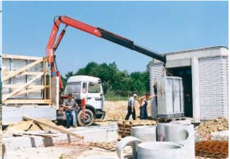
Istovar ormara sekundarne opreme u relejnu kućicu RK 200
