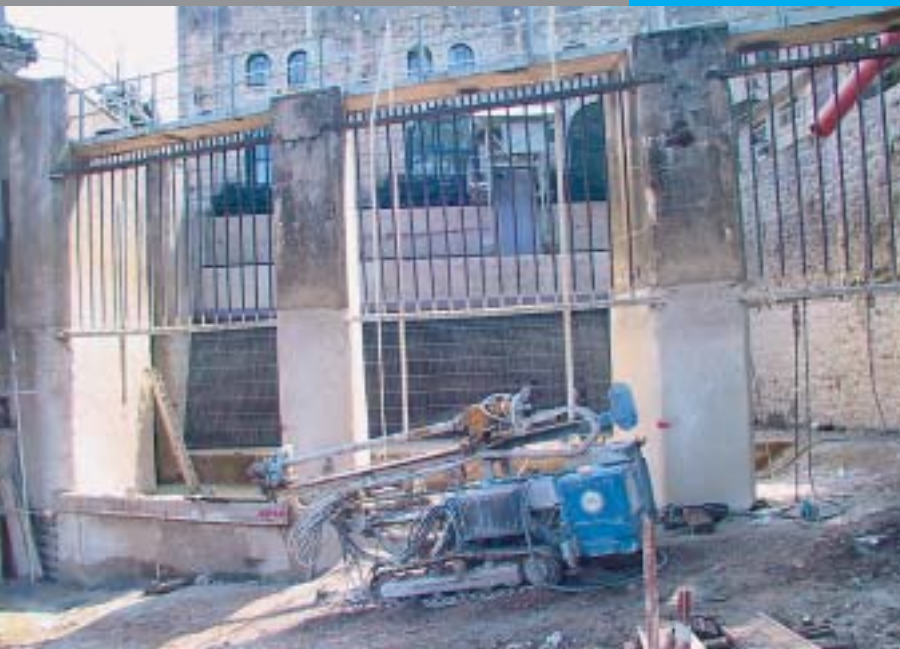
Zahtjevni radovi na sanaciji temeljenog tla i zgrada HE Ozalj 1
