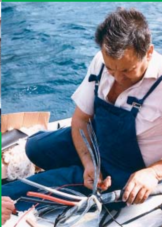
Izrada spojnice na podmorskom kabelu u Mljetskom jezeru
