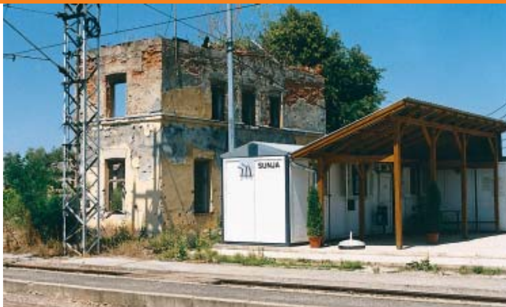
Na željezničkoj postaji uskoro će započeti izgradnja novog modernog željezničkog kolodvora
