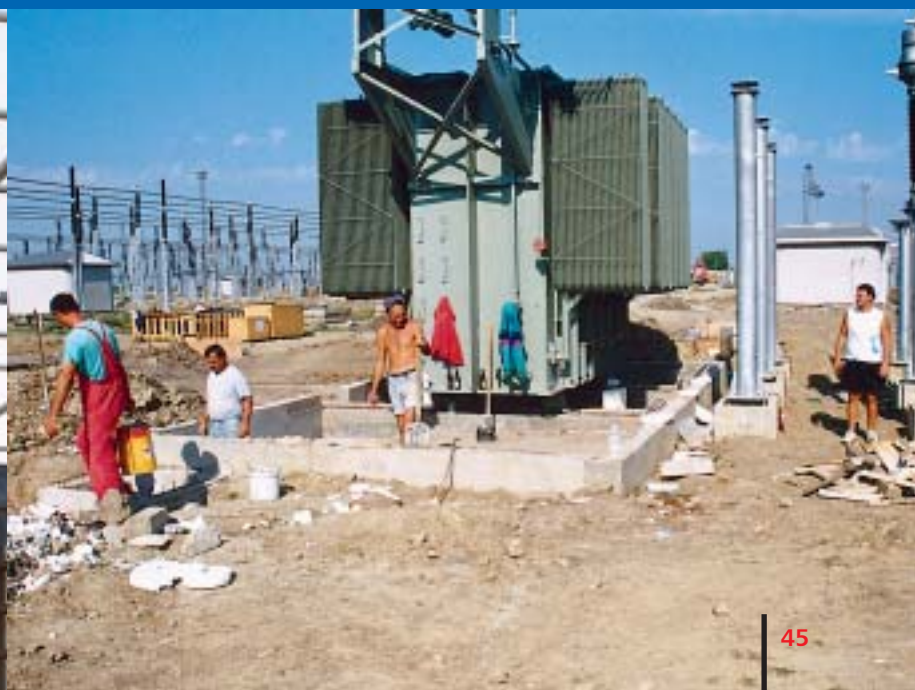
Završni radovi na montaži prigušnice 110 kV 50 Mvar
