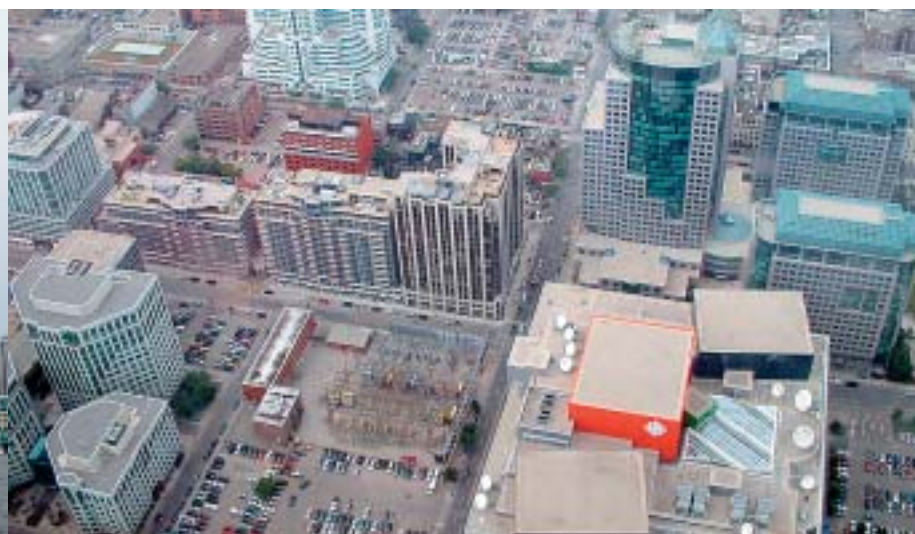
Transformatorska stanica otvorene izvedbe u središtu Toronta (pogled sa CN tornja)
