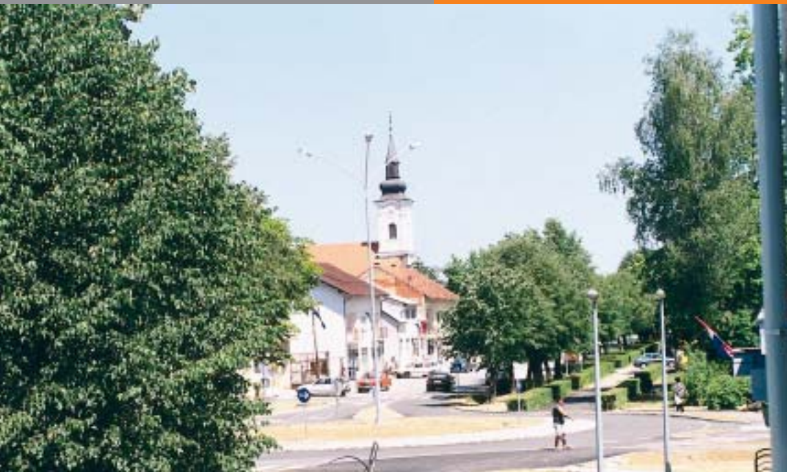
Pogled na Sunju, njezinu obnovljenu crkvu i novi kružni tok u središtu grada
