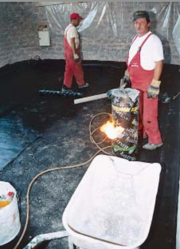
U unutrašnjosti upravljačke zgrade dovršava se hidroizolacija podova
