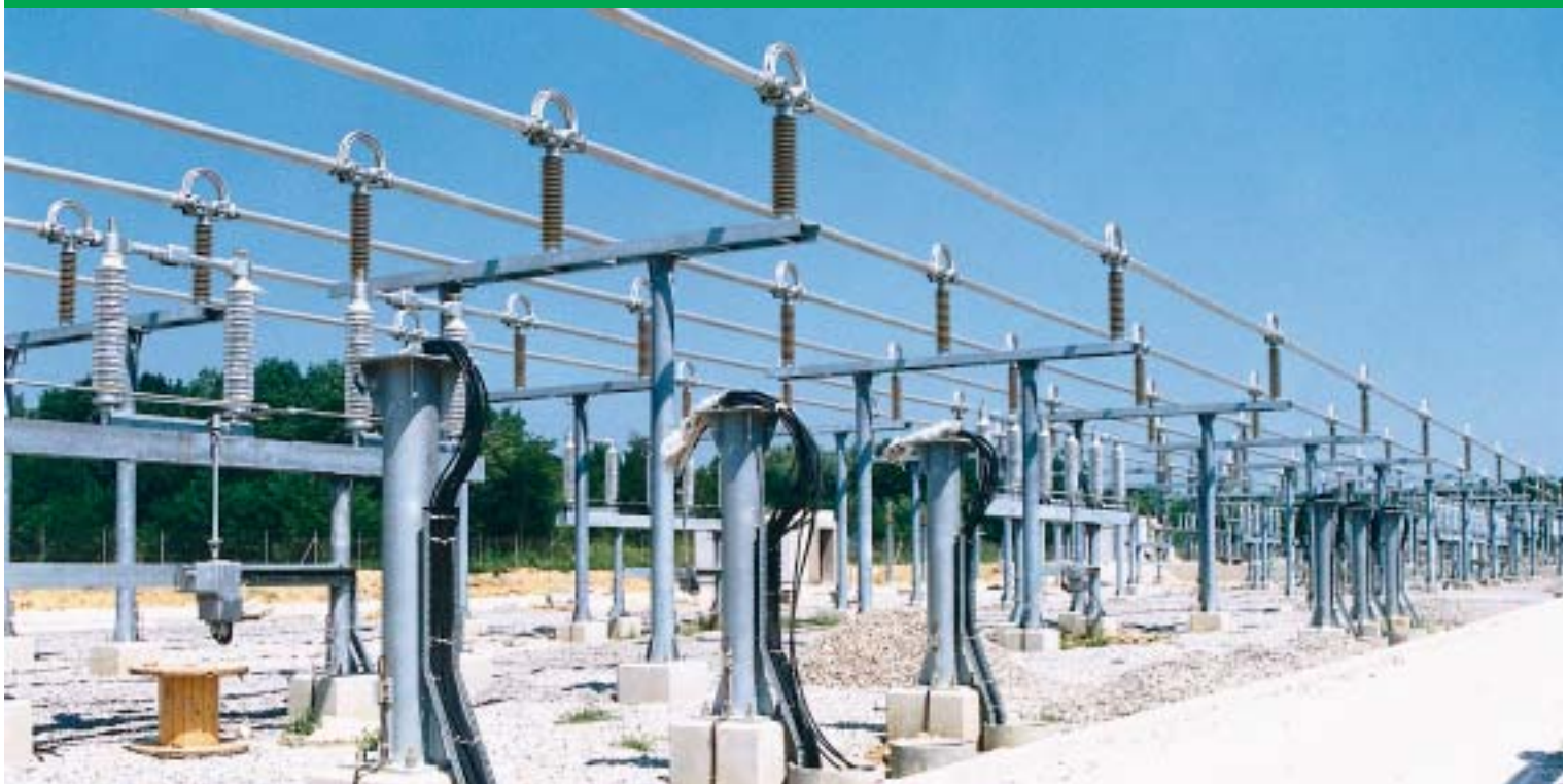
Sve je spremno za spajanje strujnih mjernih transformatora u 110 kV polju
