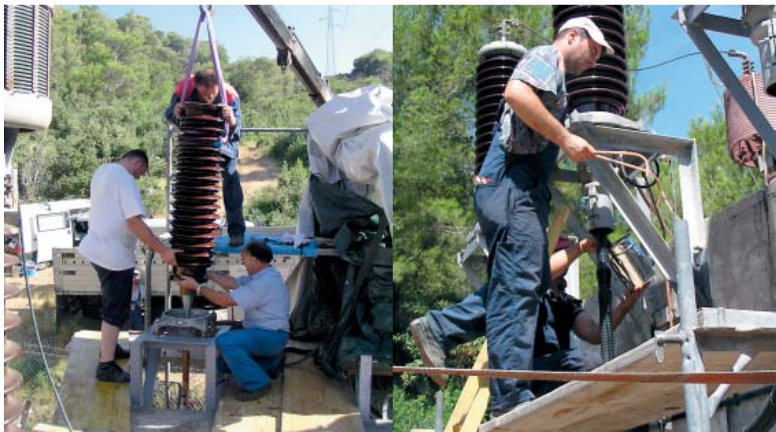
Zamjena kabelskih završnica u KS 110 kV Travna na otoku Hvaru obavljena je uspješno u srcu turističke sezone
