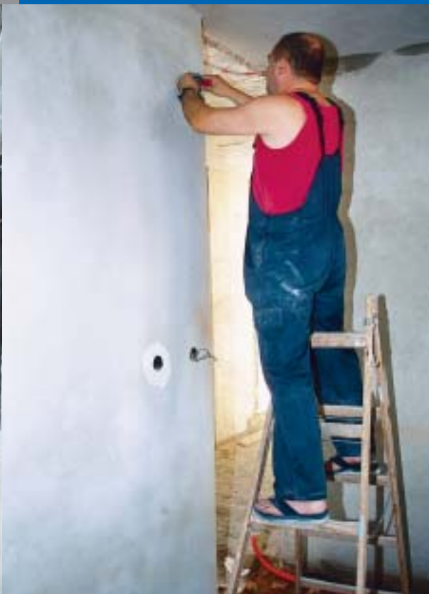
U donjoj etaži upravljačke zgrade spajaju se električne instalacije
