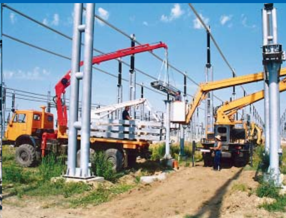
Završni radovi postavljanja postolja nosača rastavljača 400 kV
