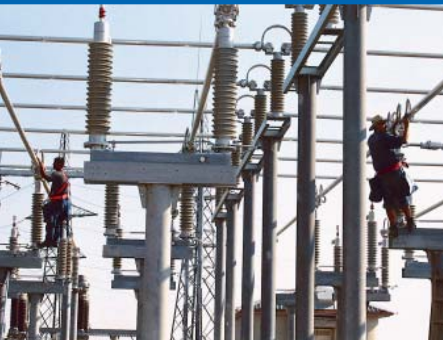
Uređuju se spojni vodovi na vodnim poljima 110 kV
