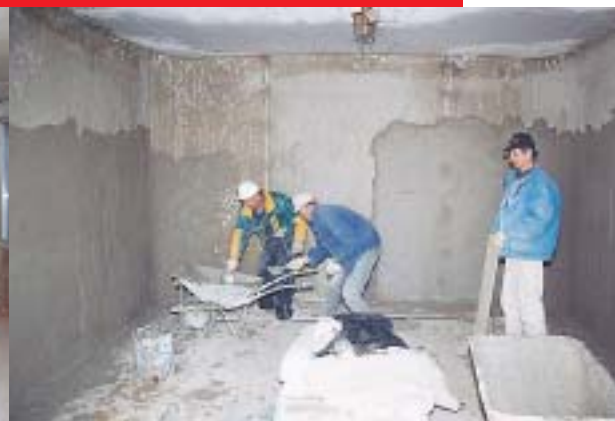
Završni poslovi žbukanja relearnih kućica
