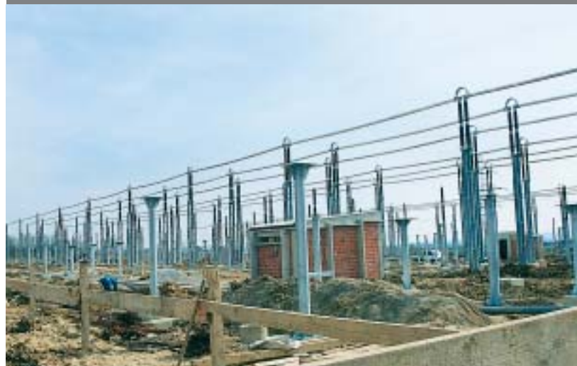
Jednopolni uzemljivači sabirničkih sustava 110 kV
