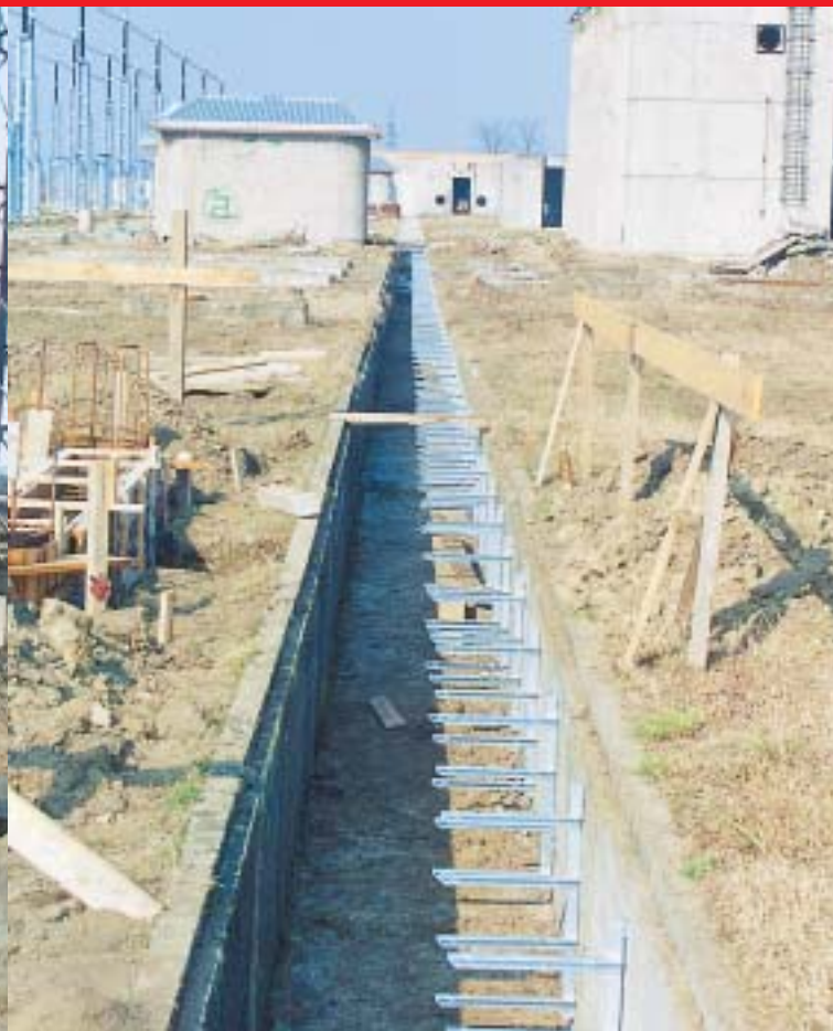
U sanirane kableske kanale ugrađene su police za kabele
