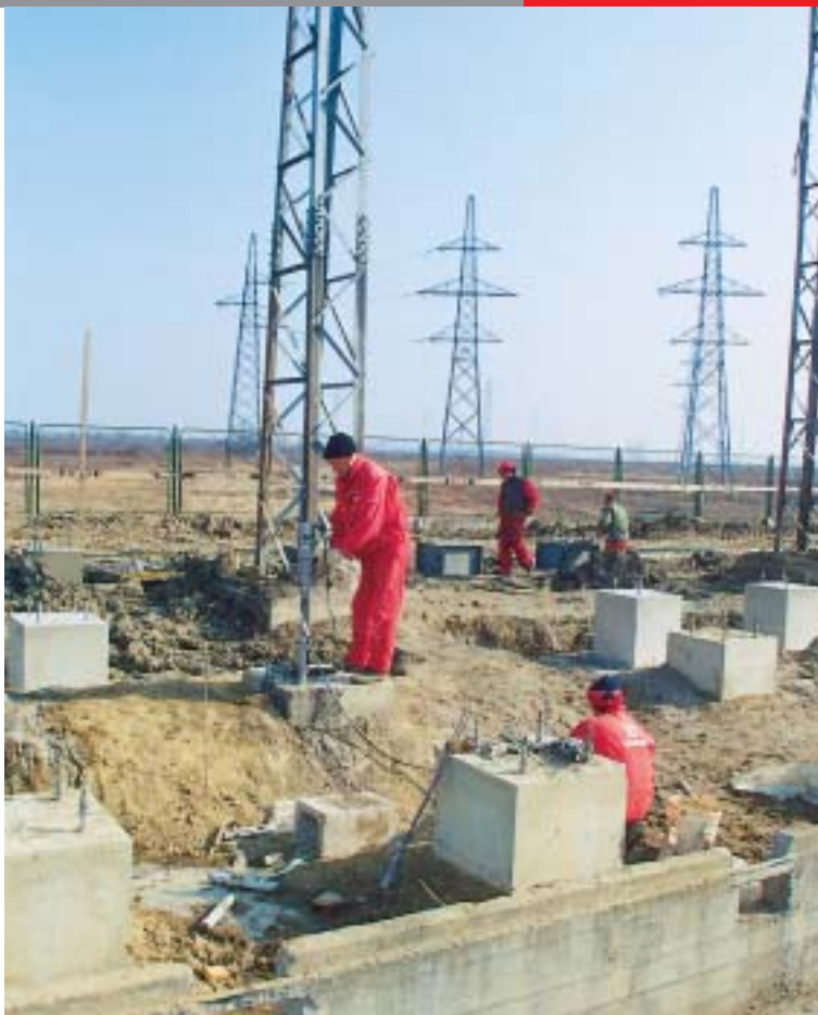
Priprema preostalih temelja za prihvat opreme
