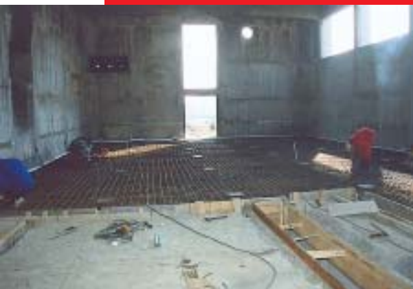
Armiranje podnog betonskog sloja u zgradi srednjeg i niskog napona
