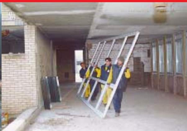
Ugradnja PVC stolarije u upravljačkoj zgradi
