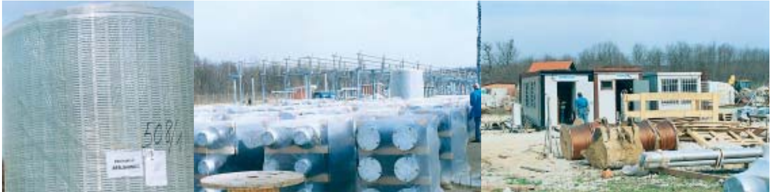
Na gradilište su dopremljene 400 kV VF prigušnice i...
