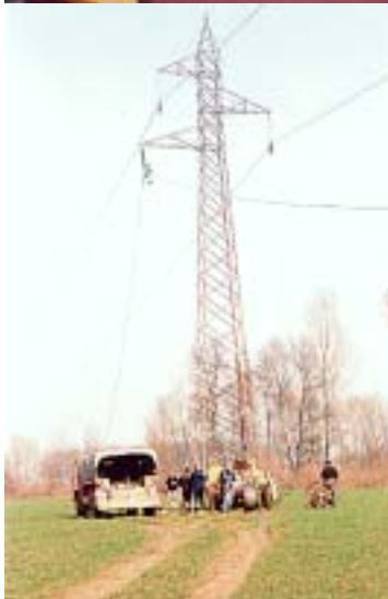
Radnici Dalekovoda na trasi DV Đakovo - Gradačac razvlače vodiče
