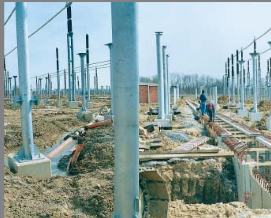
Kableska kanalizacija (šuma cijevi koje idu od okna do okna) u postrojenju 400 kV uskoro će biti pod zemljom
