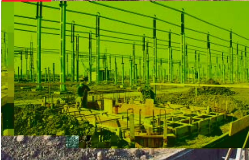
Izrada temelja za relejnu kućicu
