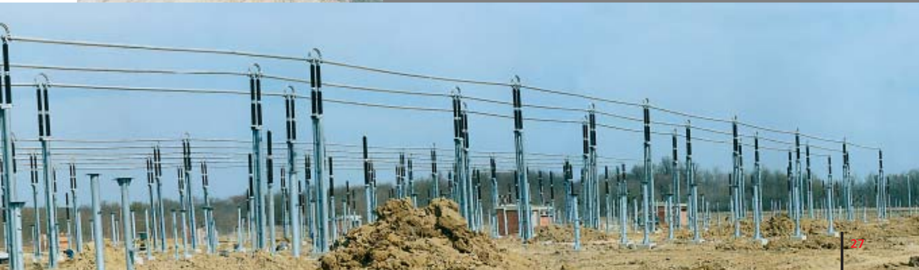
Priprema za montažu omnia ploča u kablskim kanalima postrojenja 400 kV, koje traže dobre vremenske uvjete
