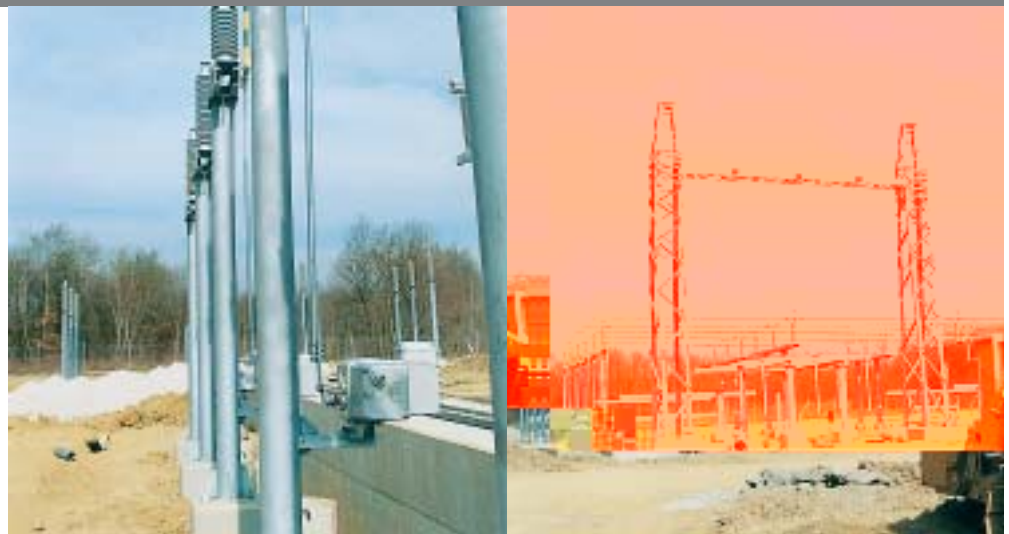
Jednopolni uzemljivači sabirničkih sustava 110 kV
