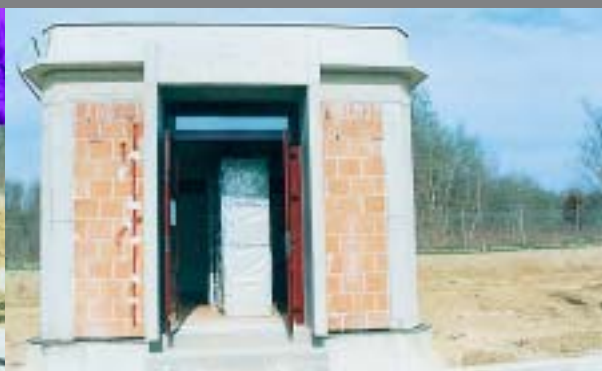
U relejnu kućicu dopremljena je oprema istosmjernog razvoda 110 kV postrojenja
