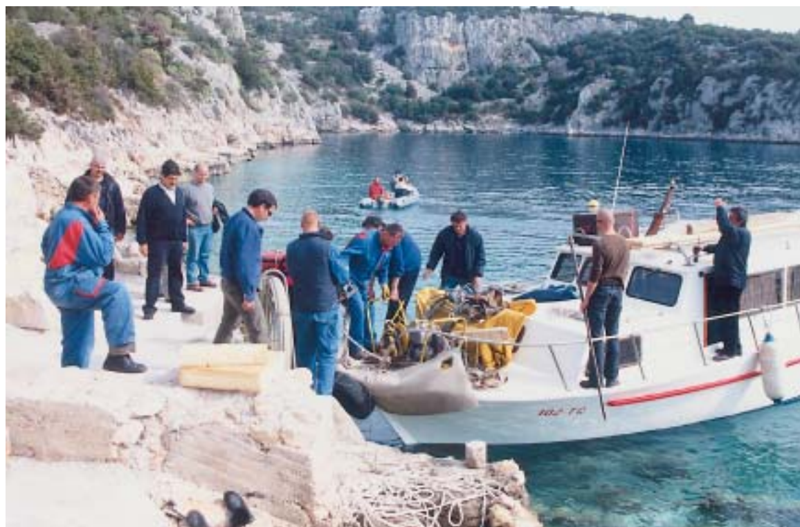
Radnici Izgradnje će povući kabel na kopnenu stranu u uvali Voluja
