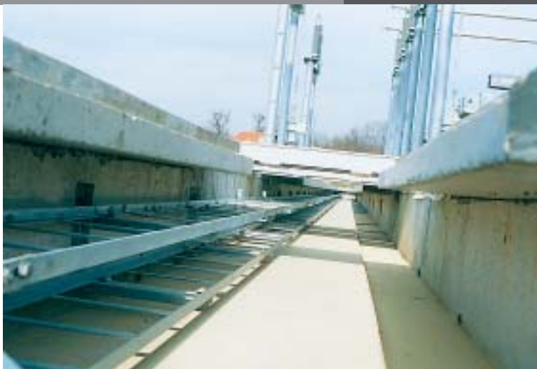
U dovršene kableske kanale u 110 kV postrojenju postavljene su police za kabele i sve je spremno za njihovo razvlačenje
