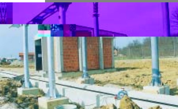
Relejna kućica 110 kV, kableska kanalizacija i okna
