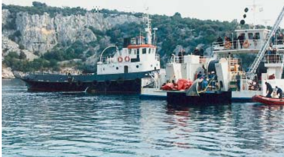
Dio pomorske flote angažirane za polaganje kabela
