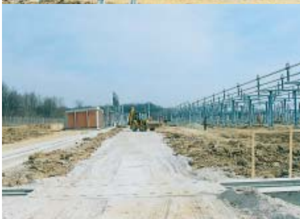
Počela je izgradnja prometnica
