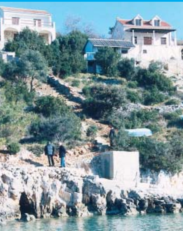
Uvala Voluja (Vinišće): na kopnu se proučava gdje je najbolje smjestiti opremu za izvlačenje kabela
