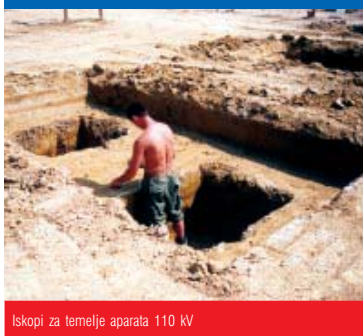
Iskopi za temelje aparata 110 kV
