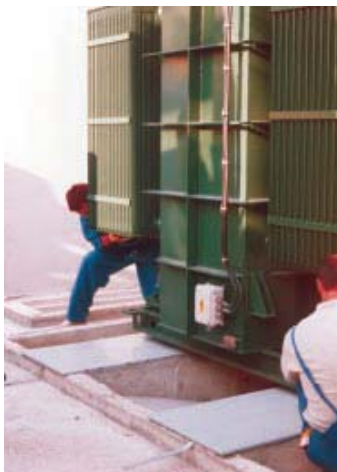
Radnici splitske Izgradnje pomažu transformatoru da sjedne na pravo mjesto
