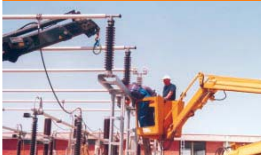
Izmjena potpornog izolatora na starom dijelu sabirnica
