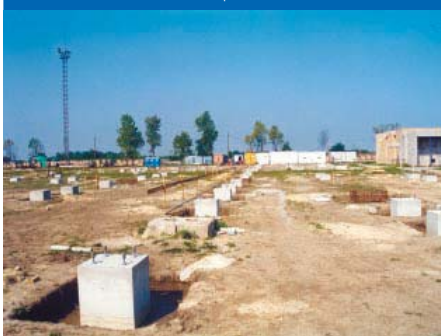
Dovršeno je betoniranje temelja i ugrađena su sidrišta za montažu novih aparata
