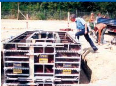
Oplata glave portala na 110 kV
