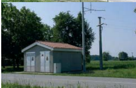
Rasklopišta 10(20) kV Ferdinandovac i ...
