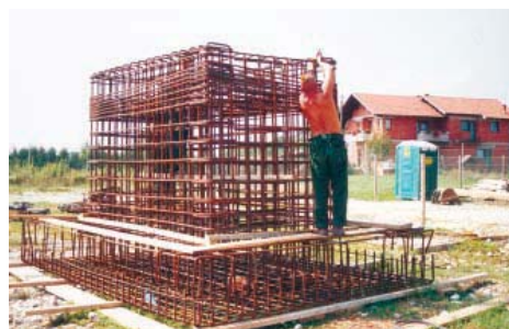
Montaža armatura za portal 110 kV
