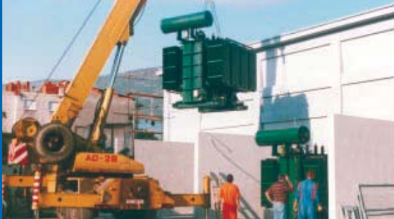
Radnici splitske Izgradnje pomažu transformatoru da sjedne na pravo mjesto
