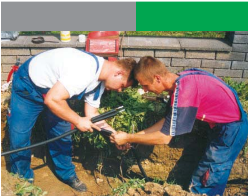
Davor Radmilović, KV monter i Ivan Gal, PKV, ugrađuju novi ormarić za podzemni priključak u ulici Cindrište
