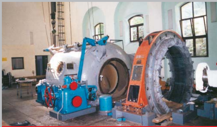
Demontirani agregat 2 - "bačva" turbine i stator generatora čekaju nove softvere
