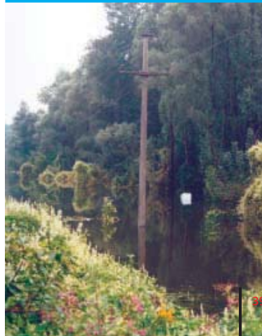
Teško oštećeni 10 kV dalekovod
