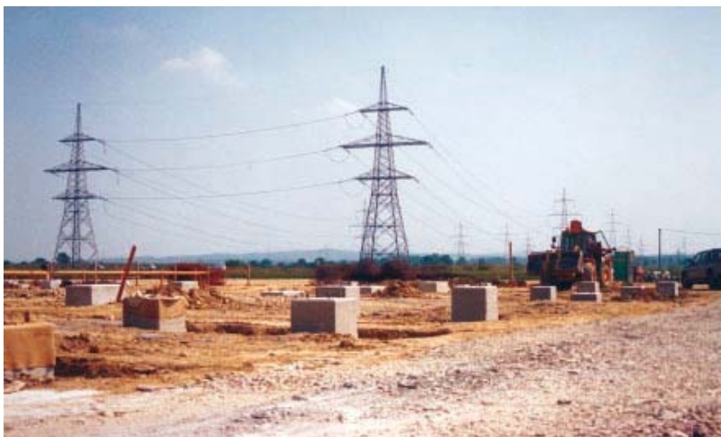
Temelji aparata na 400 kV strani, koji niču kao gljive poslije kiše
