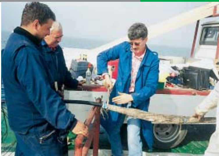
Mato Mijić, inženjer iz Službe za izgradnju Split - spajanje plašta
