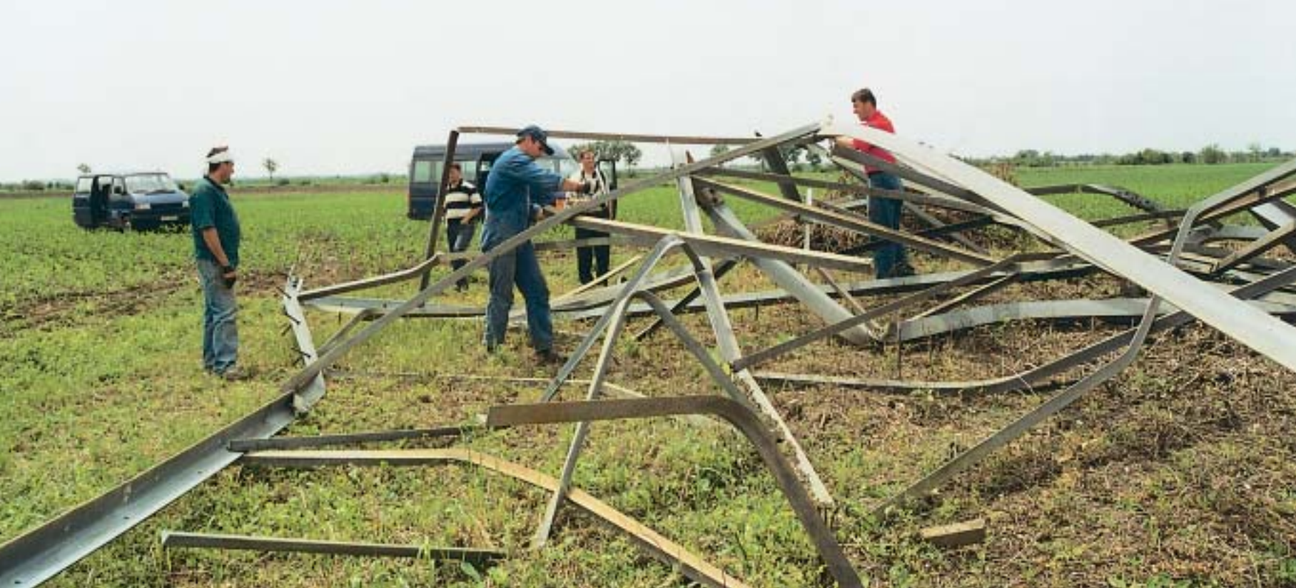
Demontaža starog uništenog stupa na trasi DV 400 kV Ernestinovo-Mladost
