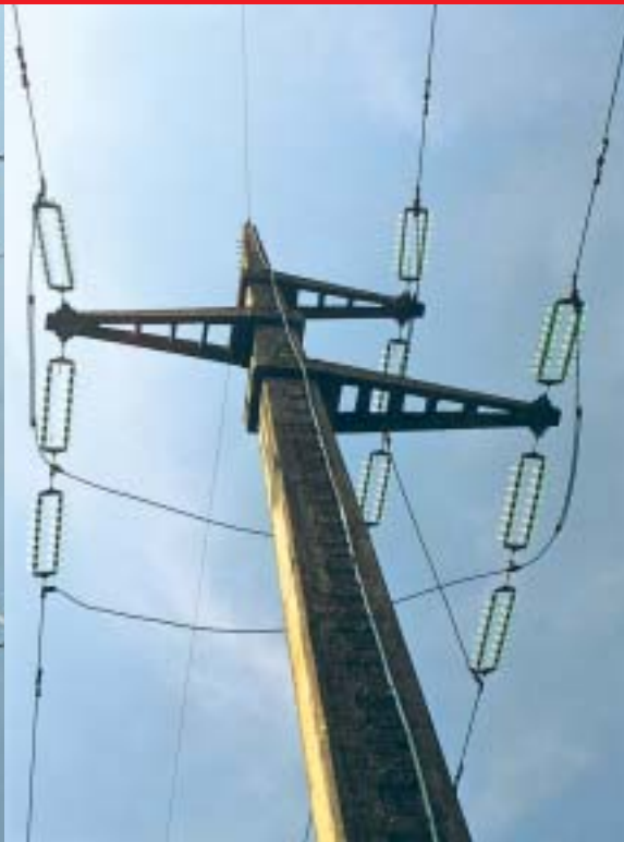
Zavješanje izolacije na stupu broj 53 sa prepletom (zamjena redosljeda faza)
