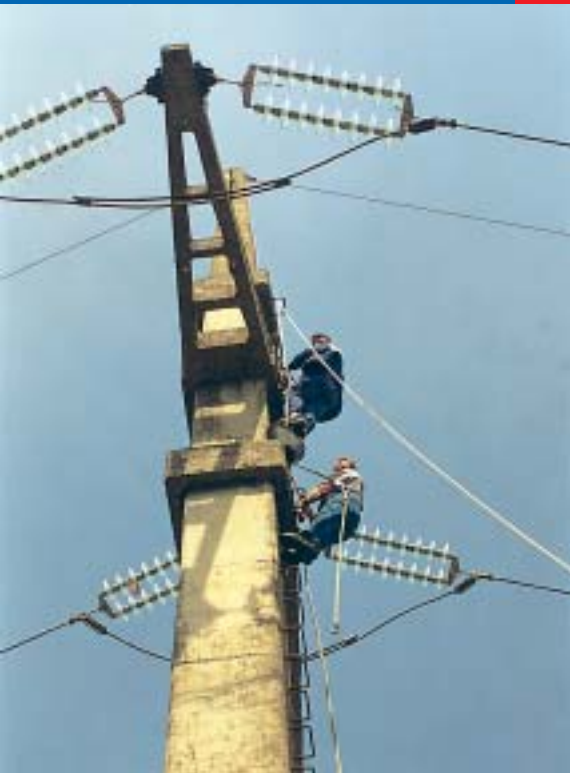
Na stupu broj 40 uhvatili smo okom kamere Mili-voja Poznanovića, grupovođu i Željka Hilca, koji učvršćuju traku za uzemljenje
