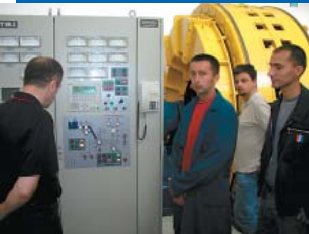
Elektrana je rekonstruirana prije tri godine, ovdje je suvremena mjerno-regulacijska oprema
