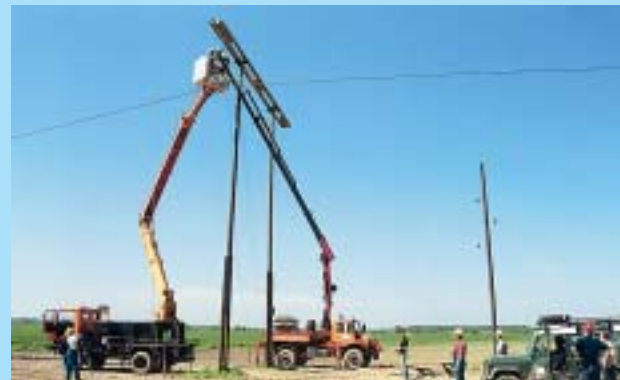
Prigodom sanacije, ekipa za dalekovode PrP Osijek na dio-nici dalekovoda 220 kV službenog naziva 1505/3, pojačala je noge portalnih stupova i zamijenila konzole, jer ovaj dio dalekovoda, premda privremen od 1993. godine, mora raditi do dovršetka obnove TS Ernestinovo i pripadnih dalekovoda
