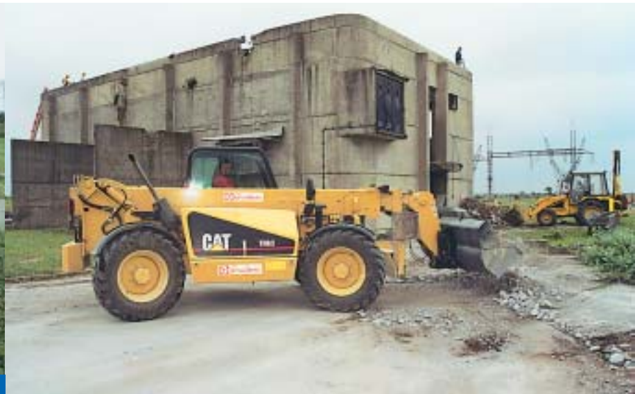
Zgrada srednjeg i niskog napona skoro je raščišćena
