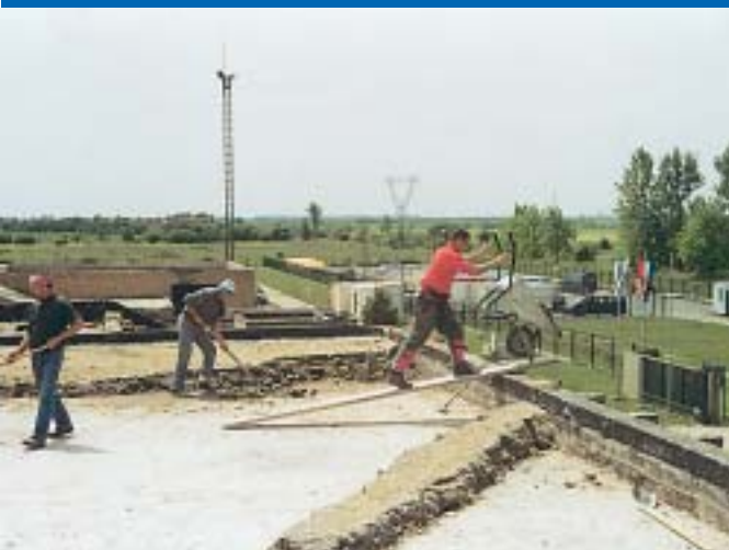
Skidanje stare izolacije s krova glavne zgrade
