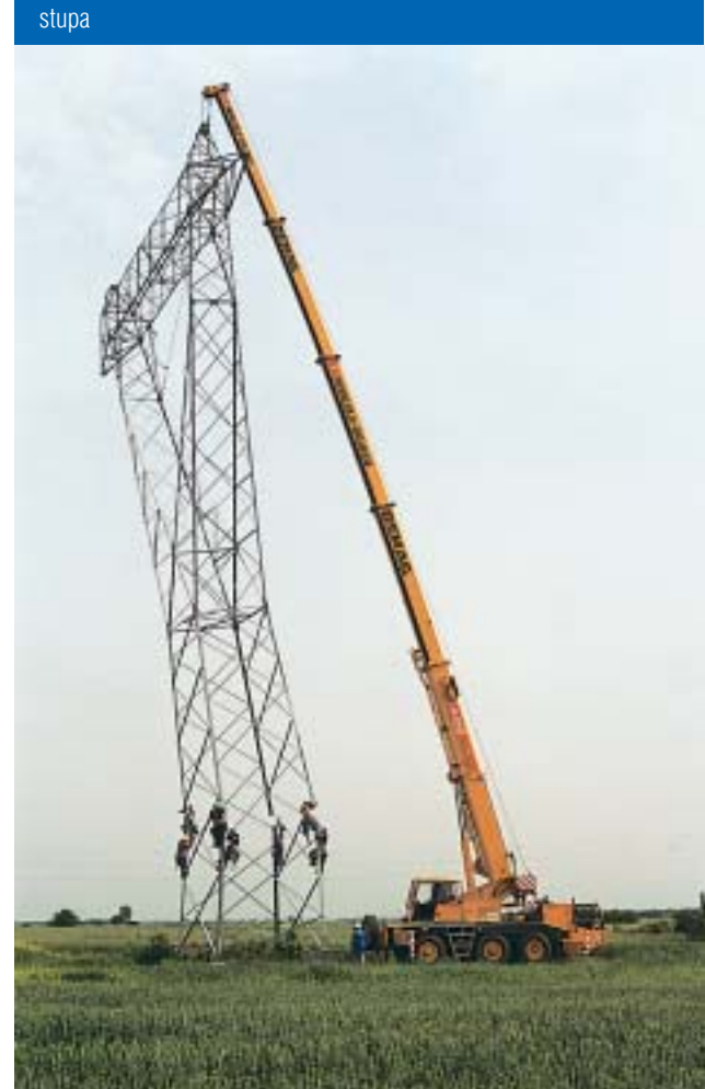
Izvrježbanost i stručnost dalekovodaša : dizanje novog stupa
