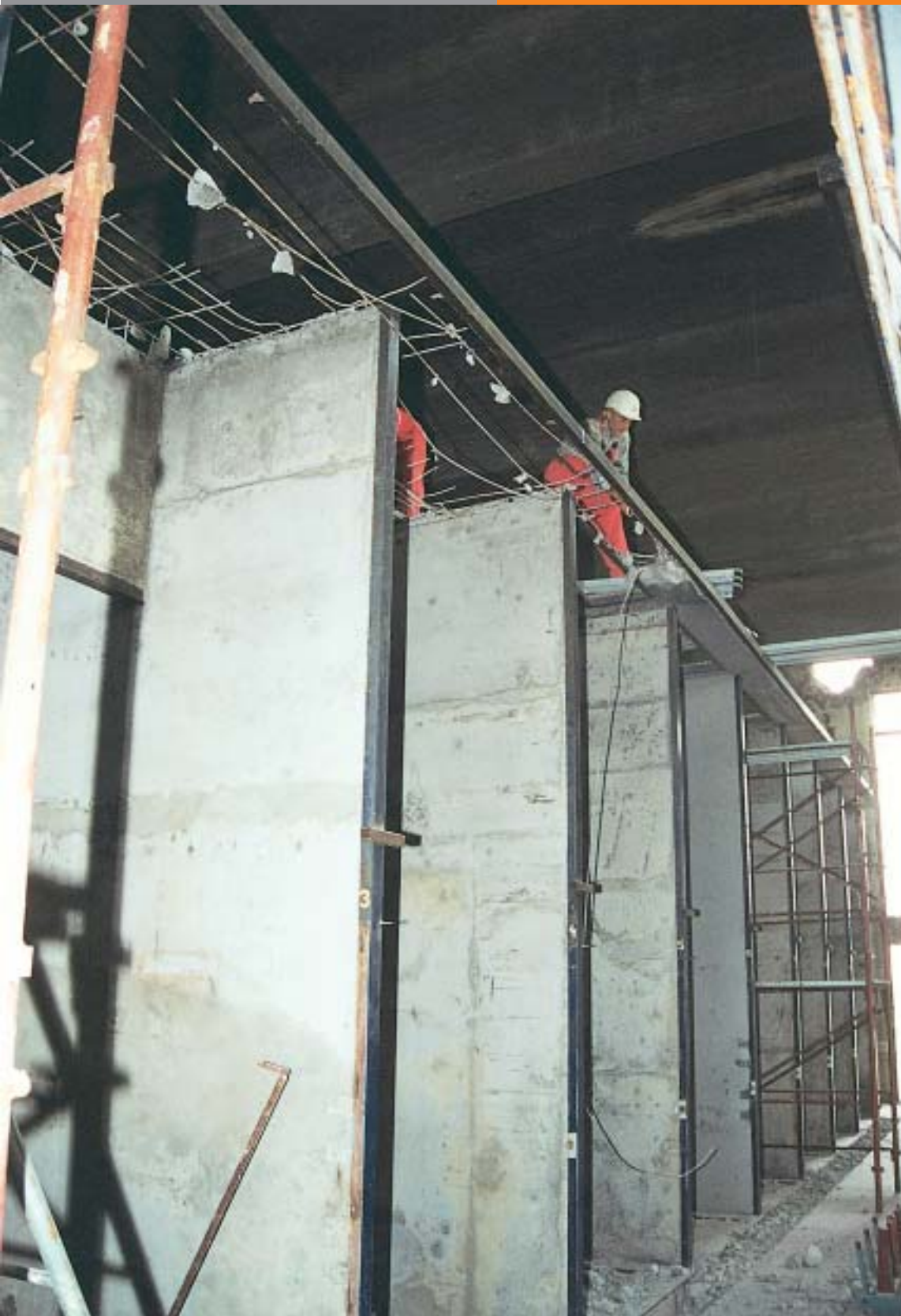
Obnova zgrade budućeg 35 kV postrojenja
