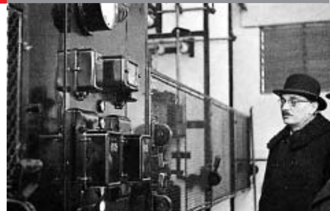
Transformatorska stanica 10 kV u Bjelovaru
