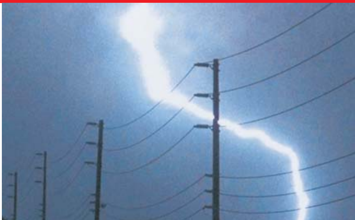
Izravan udar munje u vod na drvenim stupovima i bez zemnog užeta s mogućim zapaljenjem okolne vegetacije
