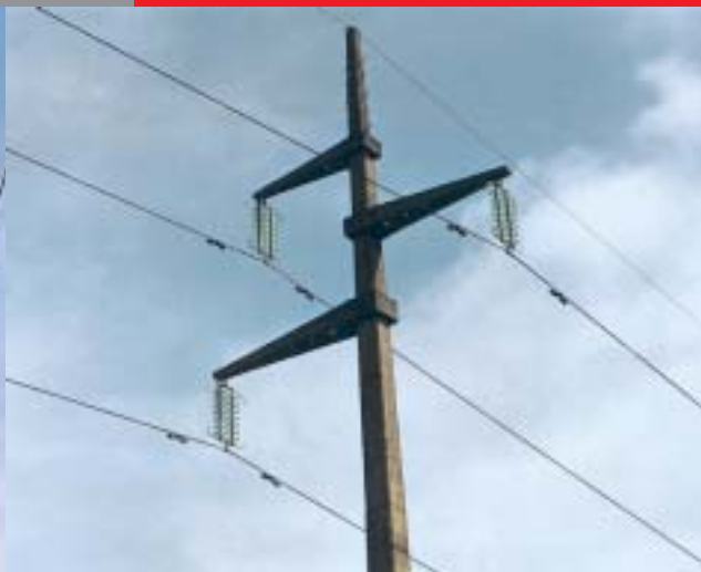
Novi stakleni izolatori sediver na stupu broj 24 DV Zabok - Jertovec
