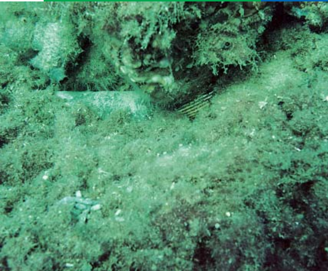
Na slici se vidi mjesto oštećenja i proboja kabela
