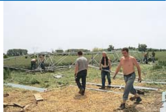
Radnici "Dalekovoda" na montaži novog stupa DV Ernestinovo-Mladost
