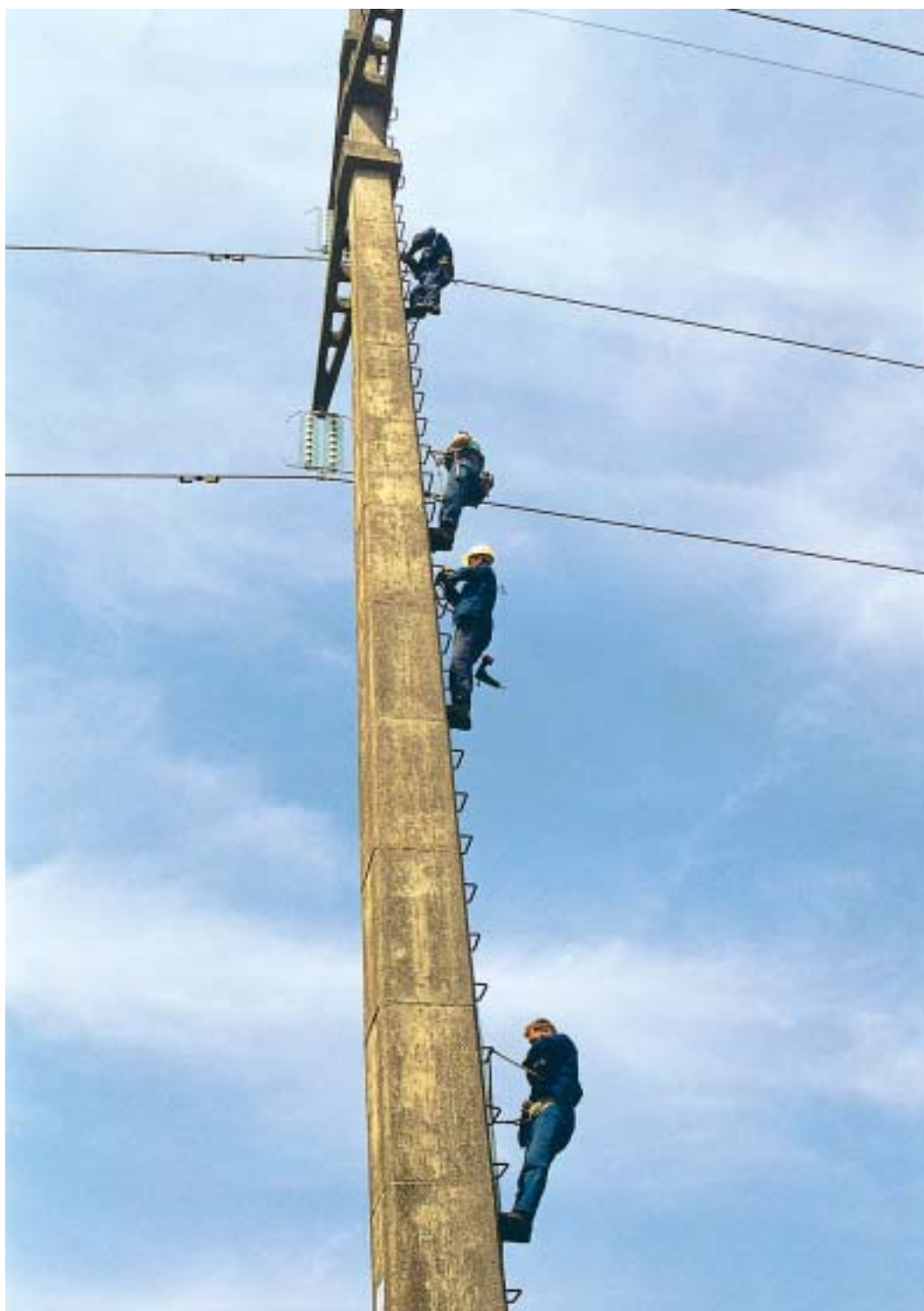
Željko Tot, Kristijan Nikić i Ante Blažević montirali su traku za uzemljenje i sada je učvršćuju niz stup broj 42
