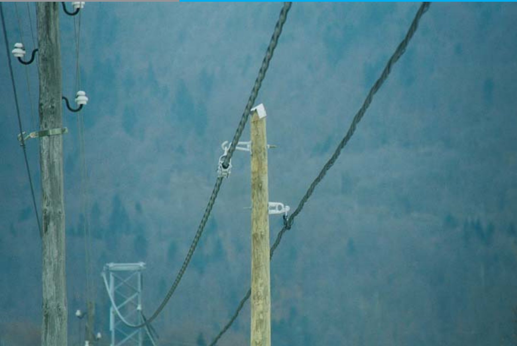
Lijevo je niski napon, a desno i niski i visoki na istom stupu. A sve u istoj trasi!
