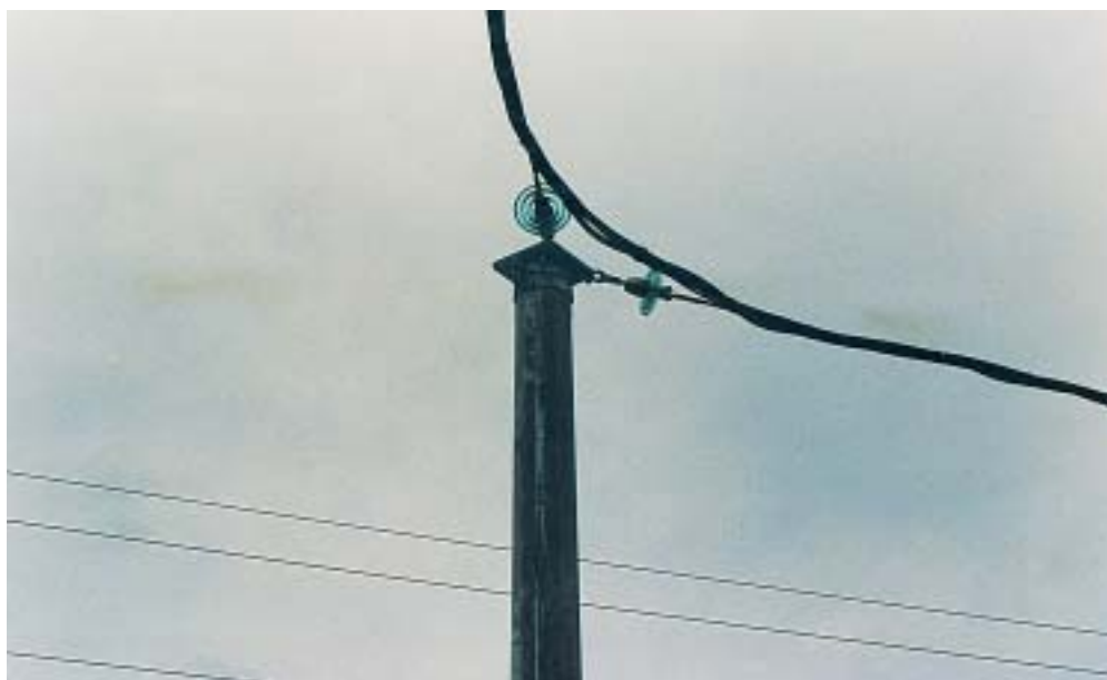
Novi način ovjesa samonosivog sklopa
