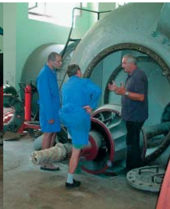
U tijeku je rasprava o načinu montaže novog sadržaja turbine
