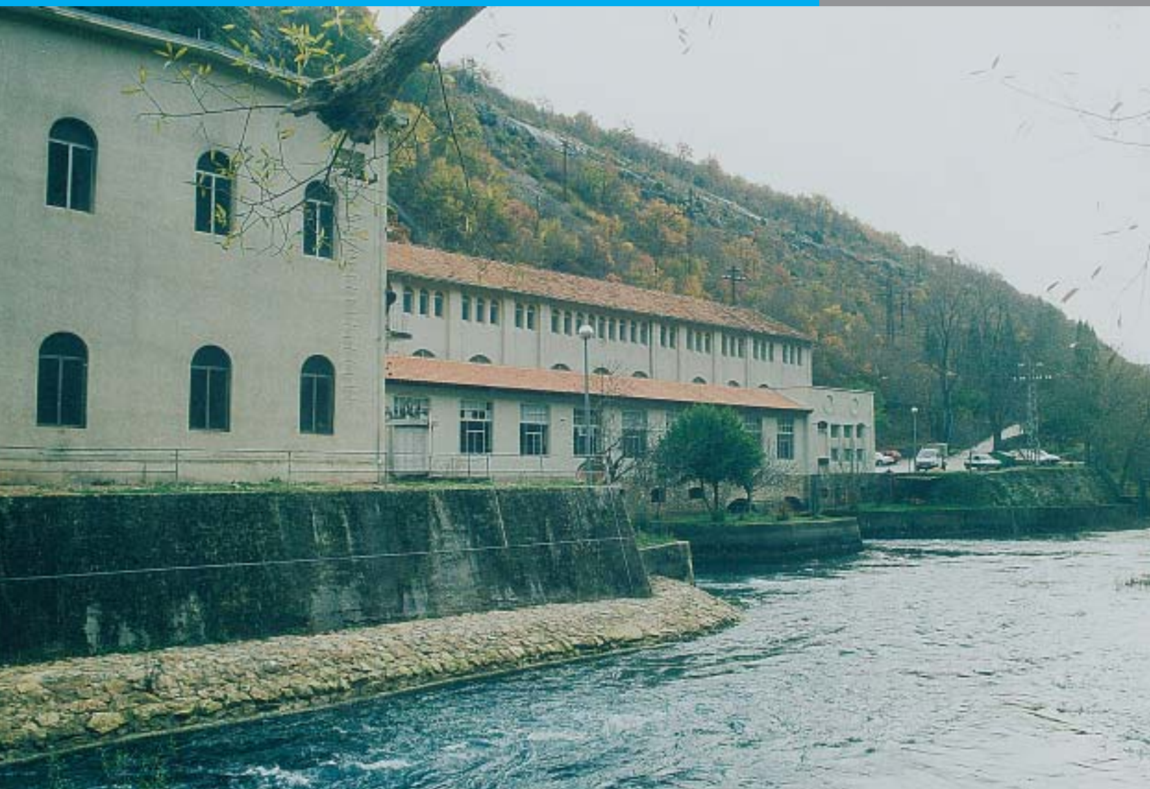
Izmijenjeni sustav dobave rashladne vode na lijevoj obali Krke u duljini od 160 m
