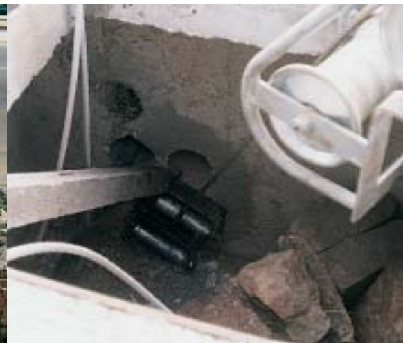
Kabel na svom putu kroz kablensku kanalizaciju
