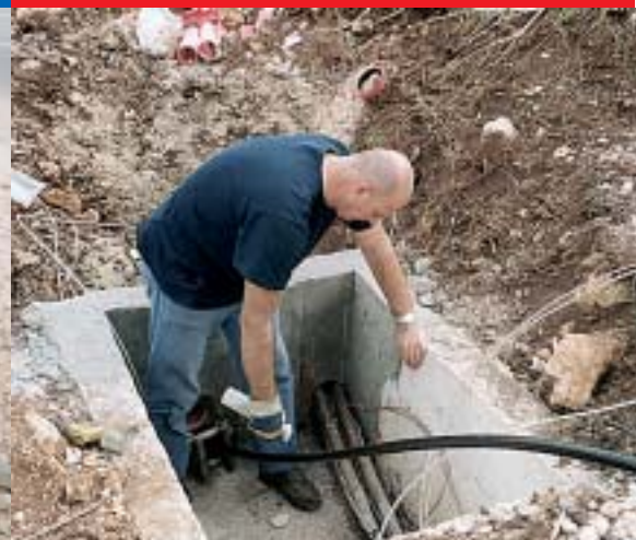
Diego Levak iz grupe za izgradnju TS i polaganje kabela NN i VN iz Pule - tekućina za podmazivanje kabela potrebna je da se ublaži trenje
