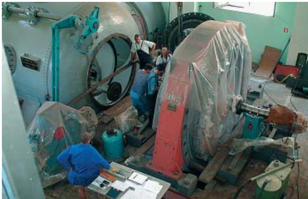
Demontaža radijalno-aksijalnog ležaja
