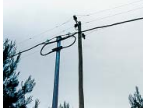
Novi način spajanja vodiča na betonskom stupu
