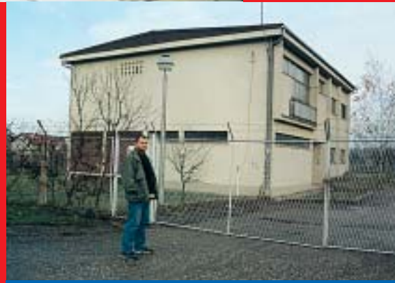
Igor Grgić, tehničar, ispred TS 35/20/10 kV Majur, središnje točke napajanja čitavog Pounja
