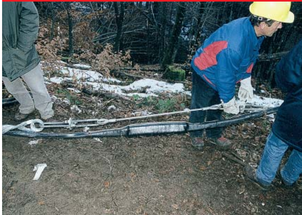
Upravo je u tijeku izrada spojnice na univerzalnom kablom nakon čega se kabel podiže na stup
