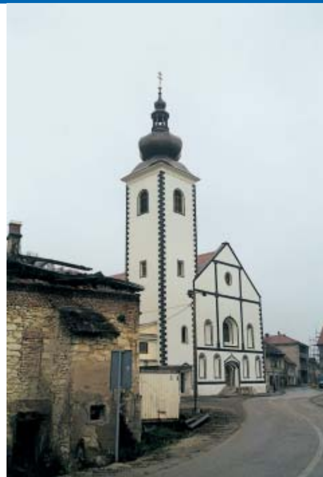
Crkva sv. Antuna obnovljena je u cijelosti, postavljena su nova zvona i elektrificirana je, a na redu je i obnova njene unutrašnjosti
