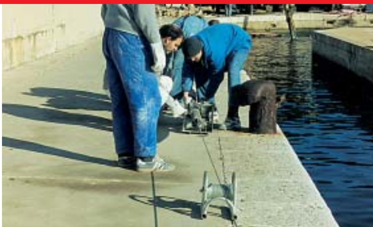
Kabel je stigao privučen sajlom
