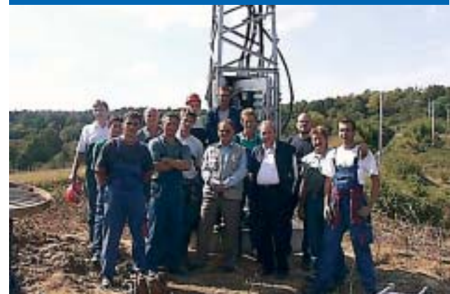
Elektraši iz Zračne mreže pred novopostavljenom stupnom trafostanicom
