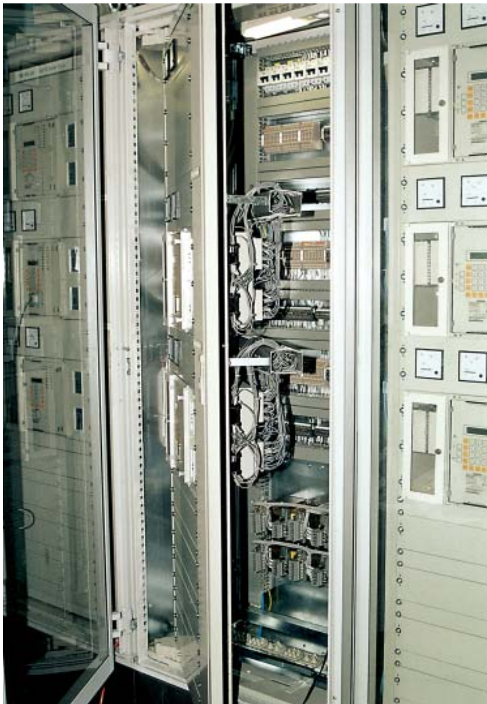
Novi suvremeni Siemensov sekundarni sustav TS Resnik...
