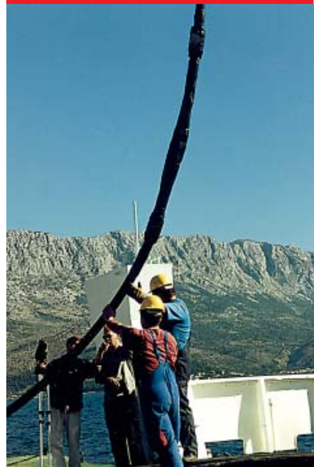
ELKINA spojnica na Raychemovoj opremi
