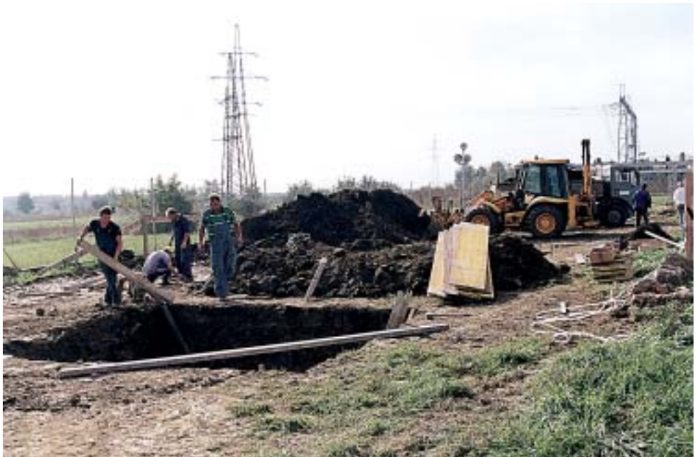
Radnici ARGITA pri kraju su s iskopavanjem i betoniranjem temelja za portale teških vodova
