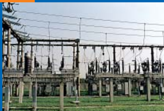
Prije šest godina započela je i druga rekonstrukcija i zamjena opreme – zamijenjeni su rastavljači 110kV i dio opreme u poljima
