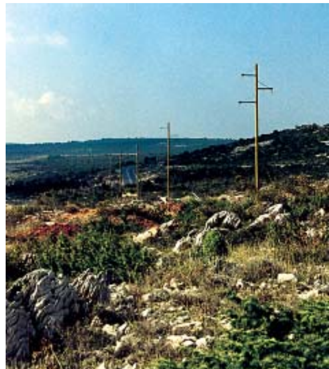
Novi dalekovod još uvijek bez vodiča, povezat će Posedarje i Maslenicu
