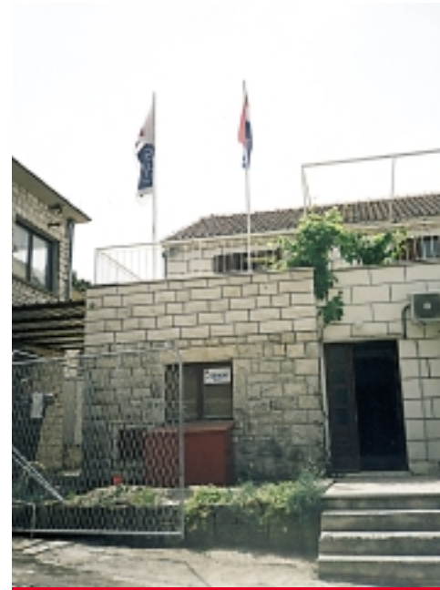
Poslovna zgrada Pogonskog ureda Korčula
