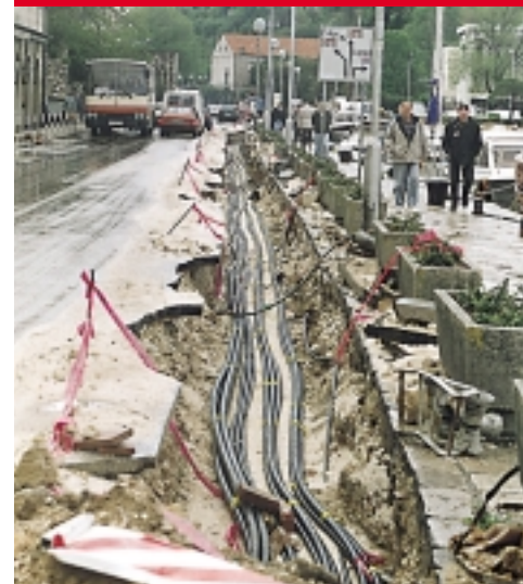
Kabliranje gruške obale
