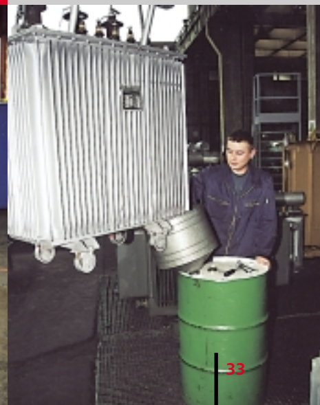
Ivan Bošnjak pri istakanju trafo-ulja prije popravka
