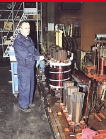
Popravak transformatora 630 kVA i Darko Hirnštajn
