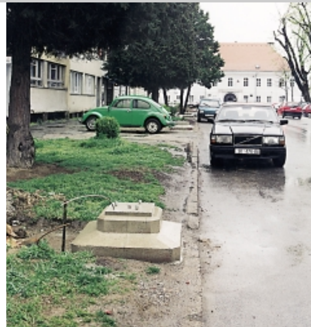
Središte Petrinje uskoro će obasjati nove lampe, za čije su stupove temelji spremni
