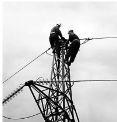
Popravlja se oštećeni DV 110 kV od TS 110/35 kV Osijek III do Osijeka II i I
