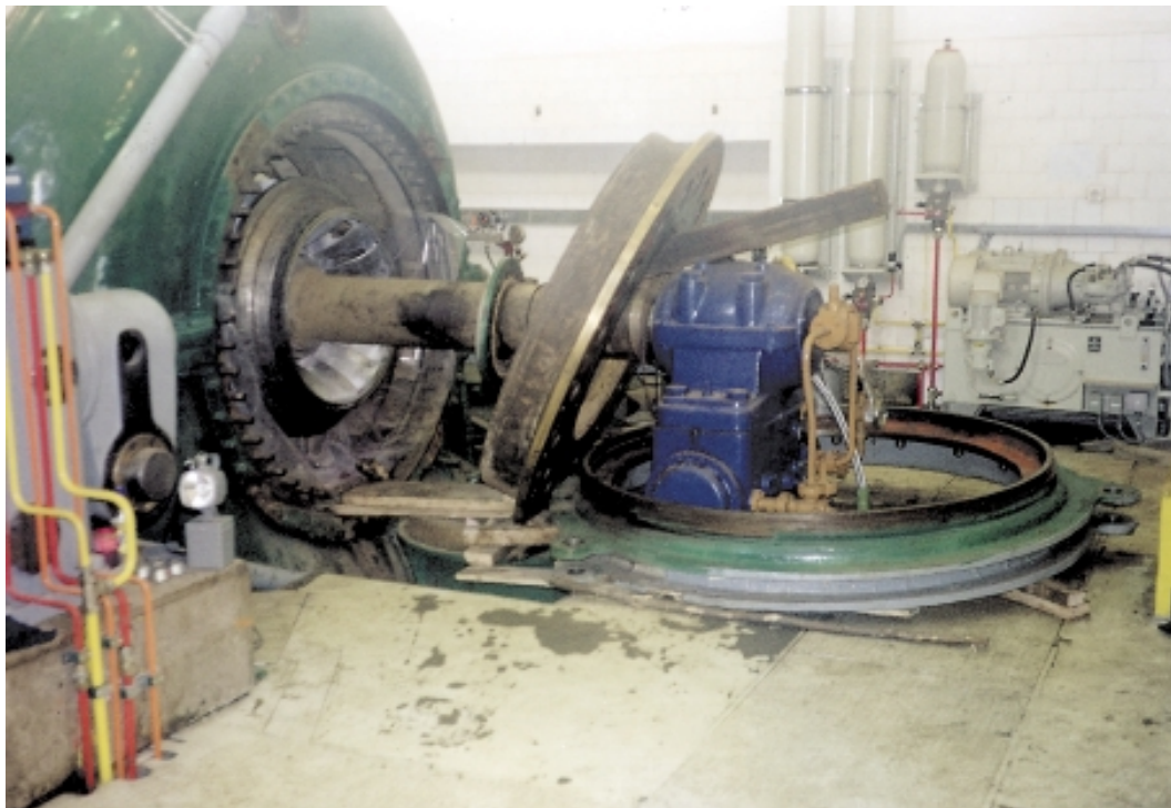
HE Miljacka rastavljanje turbinskog poklopca...
