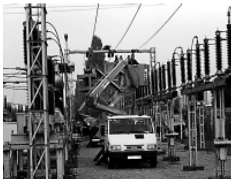
Sanaciju sabirnica TS 110/35 kV Osijek II obavljaju ekipe PrP Osijek
