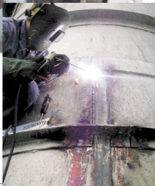
... sanacija cjevovoda zavarivanjem pukotina
