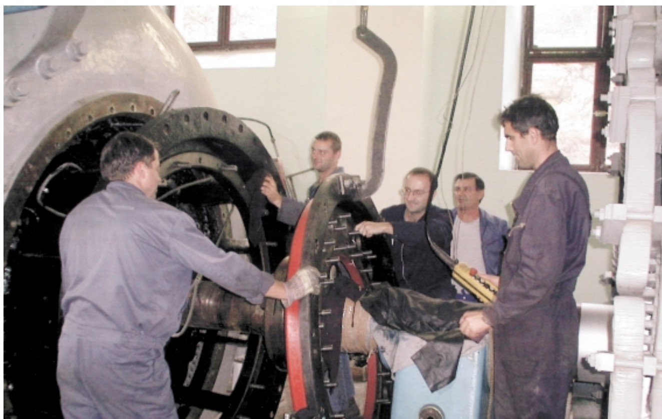
HE Jaruga: demontaža statora i privodnog aparata...
