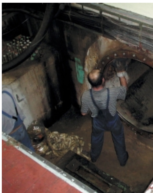
Otvor regulatora tlaka
